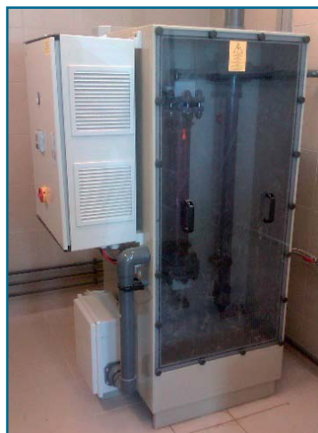
Fot. 1 Elektrolizer do wytwarzania podchlorku sodu.
