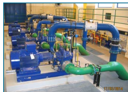
Fot. 3 Pompownia wody surowej Żesławice, 2014.
