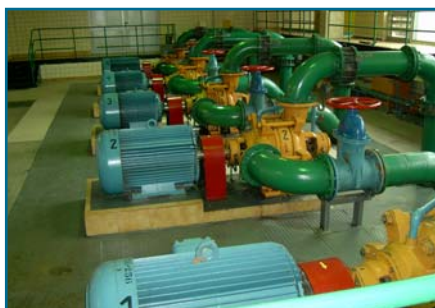
Fot. 2 Pompownia wody surowej Żesławice, lata 70-te XX w.
