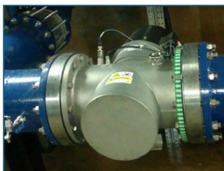
Fot. 3 Widok promiennika zamontowanego na rurociągu 300 mm zasilającym miasto Dobczyce.
